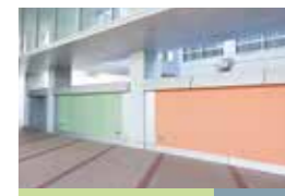
ピロティ&掲示板 C館手前
